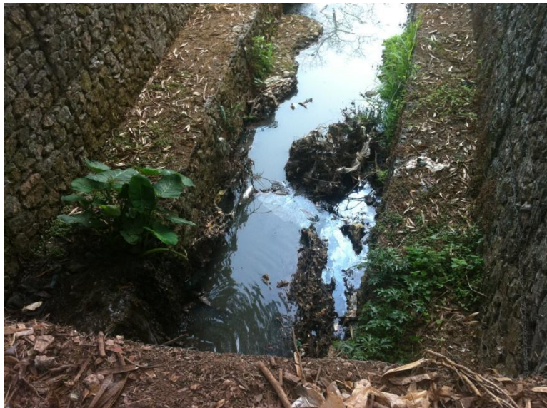
Figura 6. Imagem do córrego em trecho com muro de gabião. (Fonte: Autoria própria)
