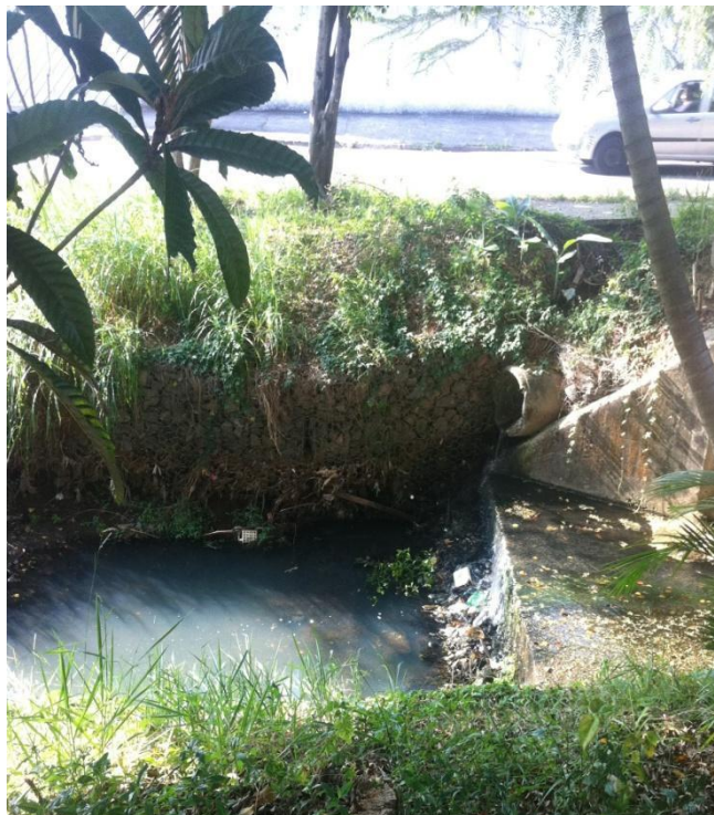
Figura 4. Imagem do córrego em trecho instável com muro de gabião. (Fonte: Autoria própria)
